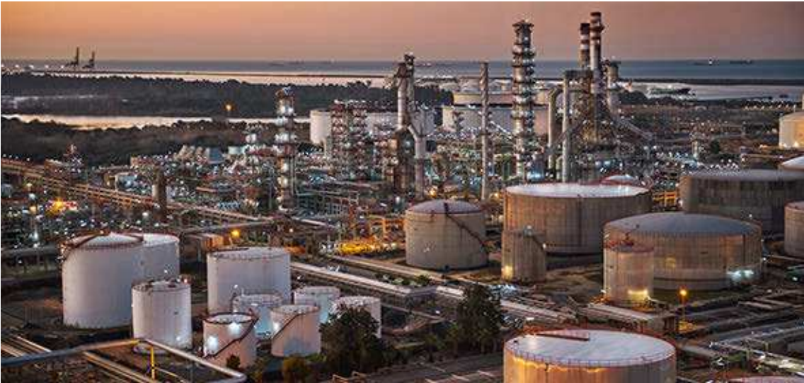
Refinería Moeve de Palos de la Frontera (Huelva). Gonzalo Puertas
