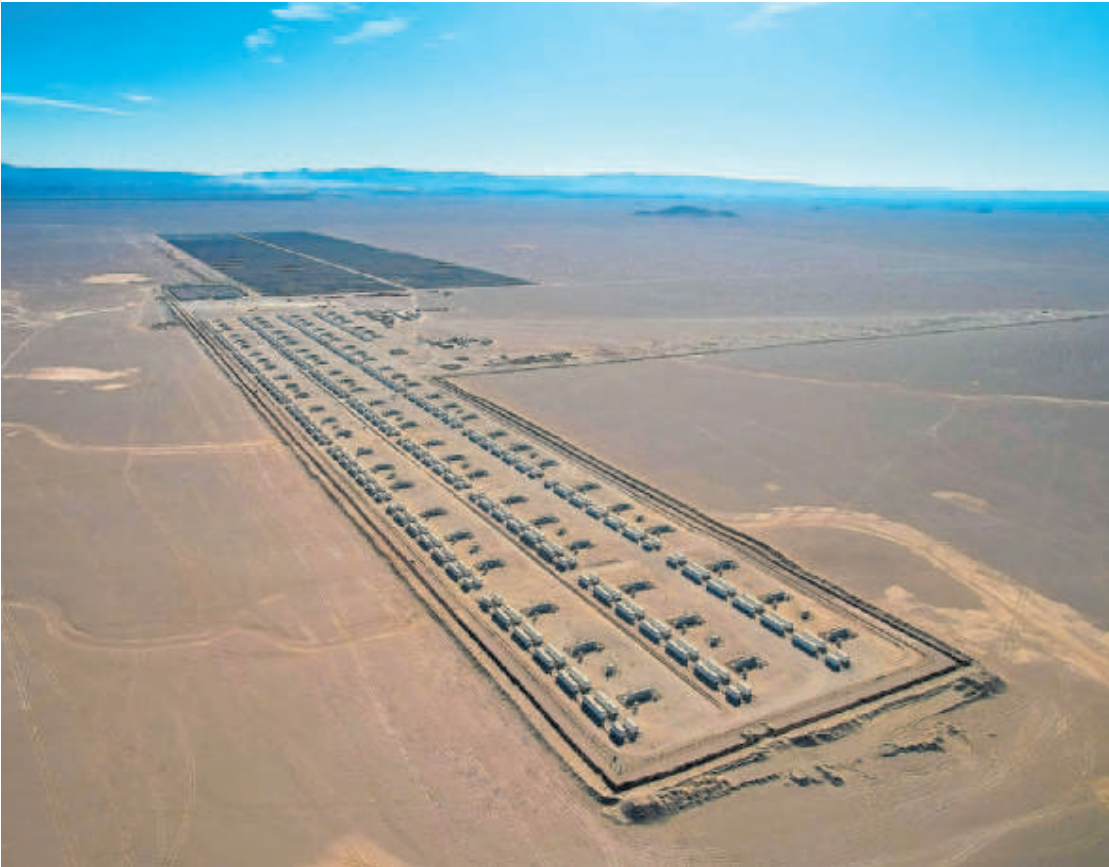
Vista aérea de Elena, planta de baterías en la región de Antofagasta (Chile), en una imagen de Grenergy.
