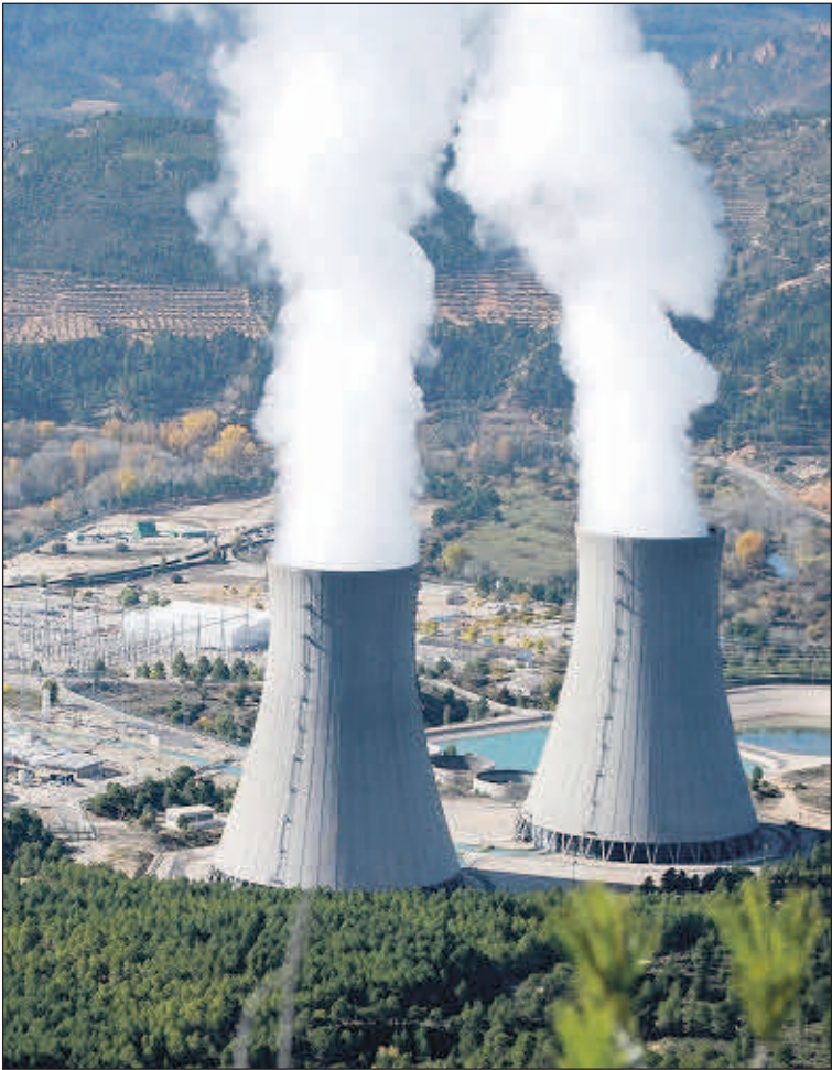
La central nuclear de Cofrentes. EE
