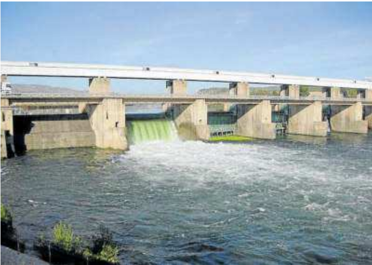
Central hidroeléctrica de Flix. Foto: Endesa
