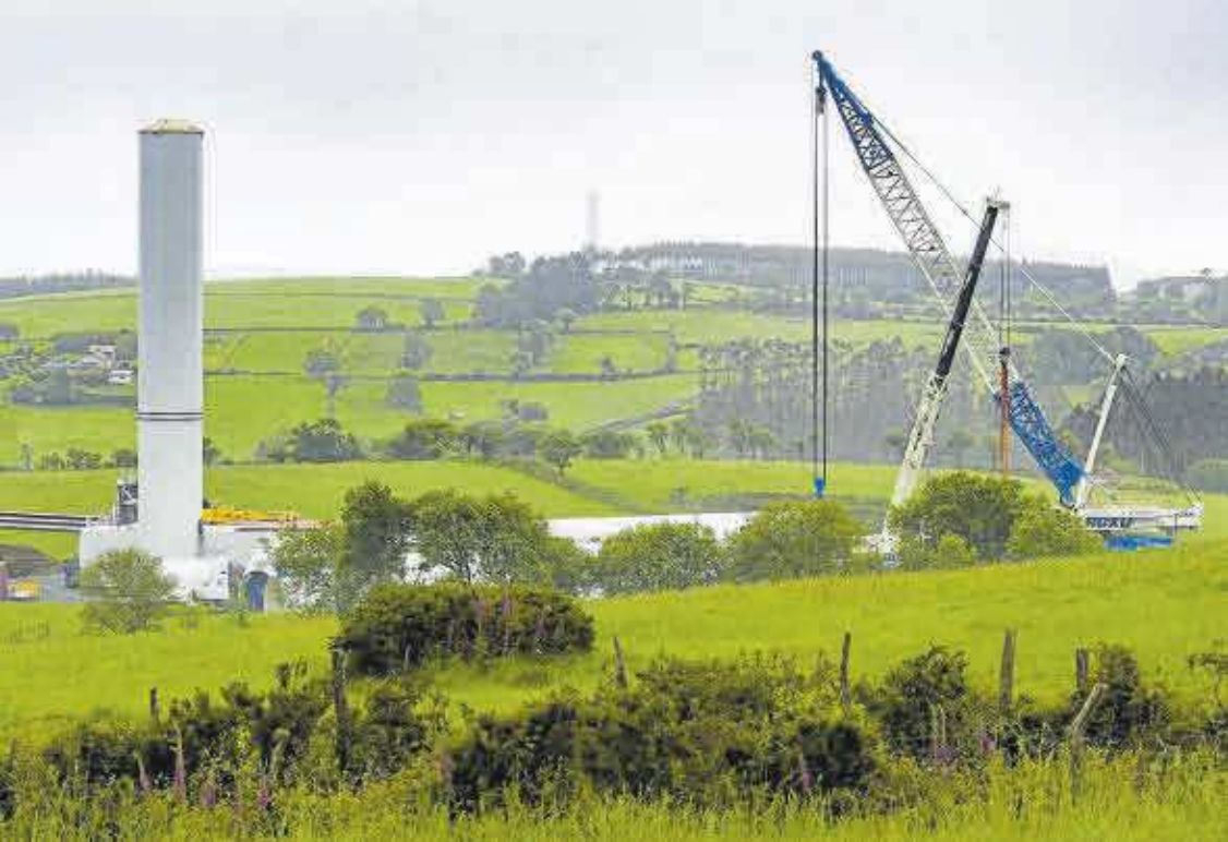
Obras de repotenciación en un parque eólico de Galicia.
