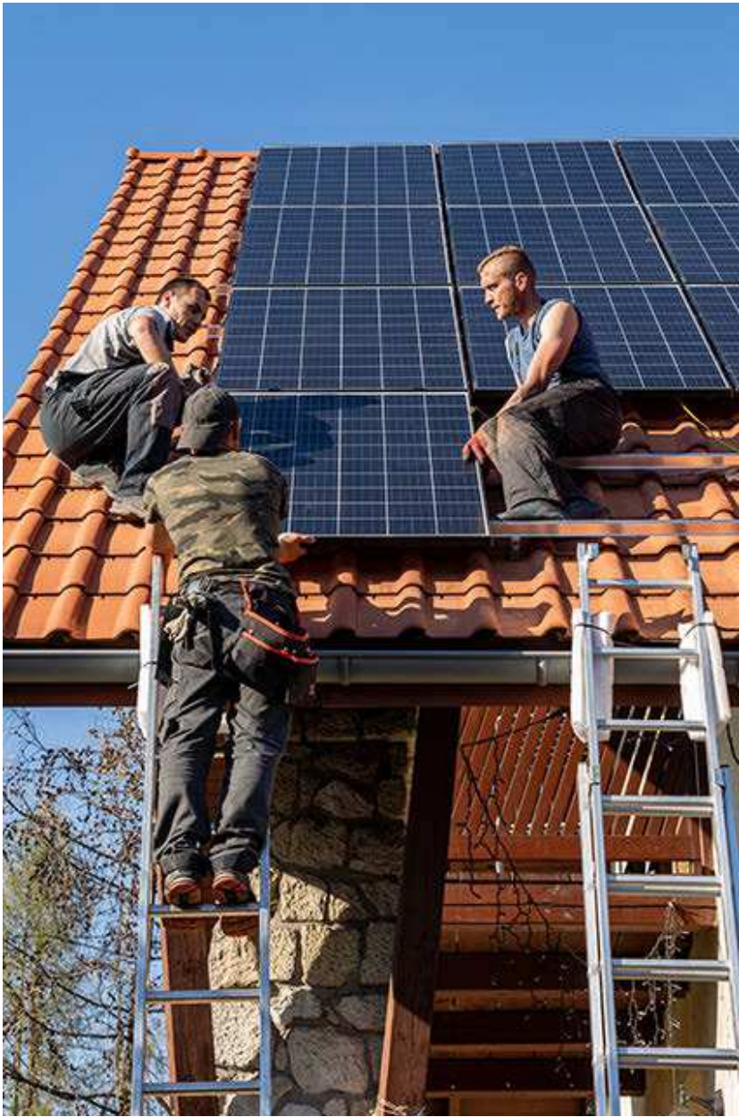
Instaladores colocan paneles solares en el tejado de una vivienda. eE
