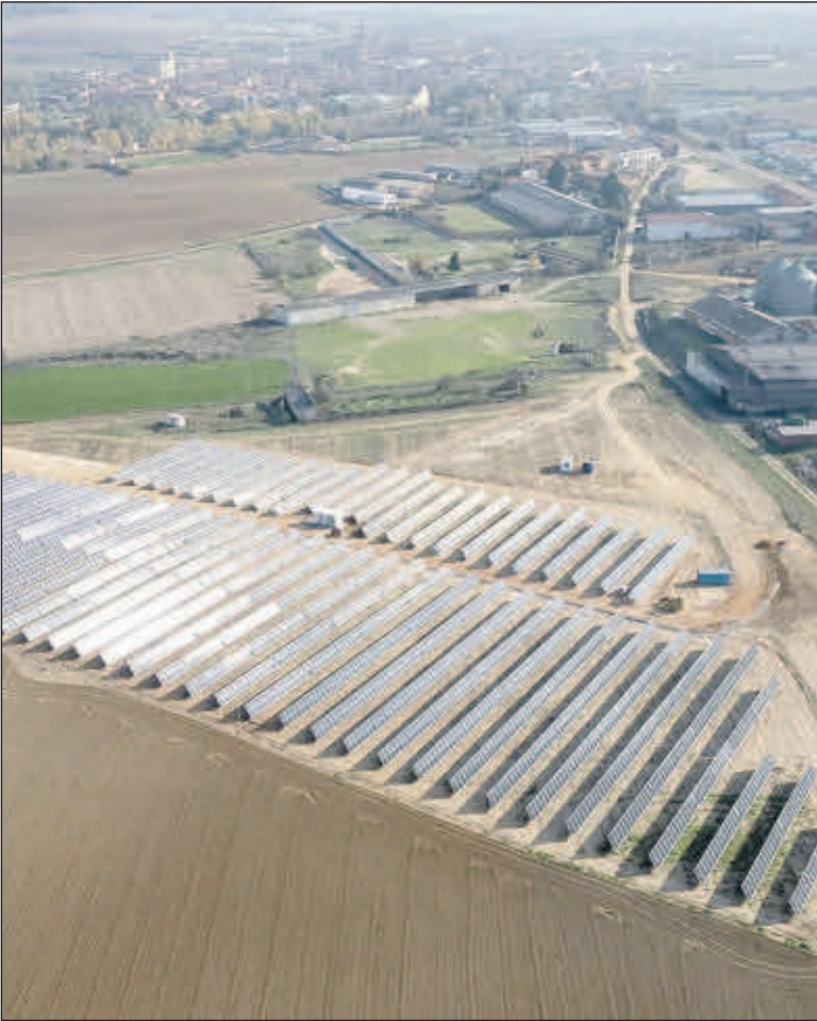
Instalaciones de NetOn Power. EE
