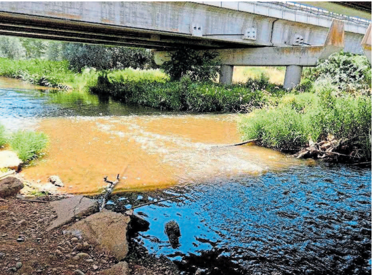
Punto de vertido de aguas residuales en el Arroyo del Reguero Grande.
