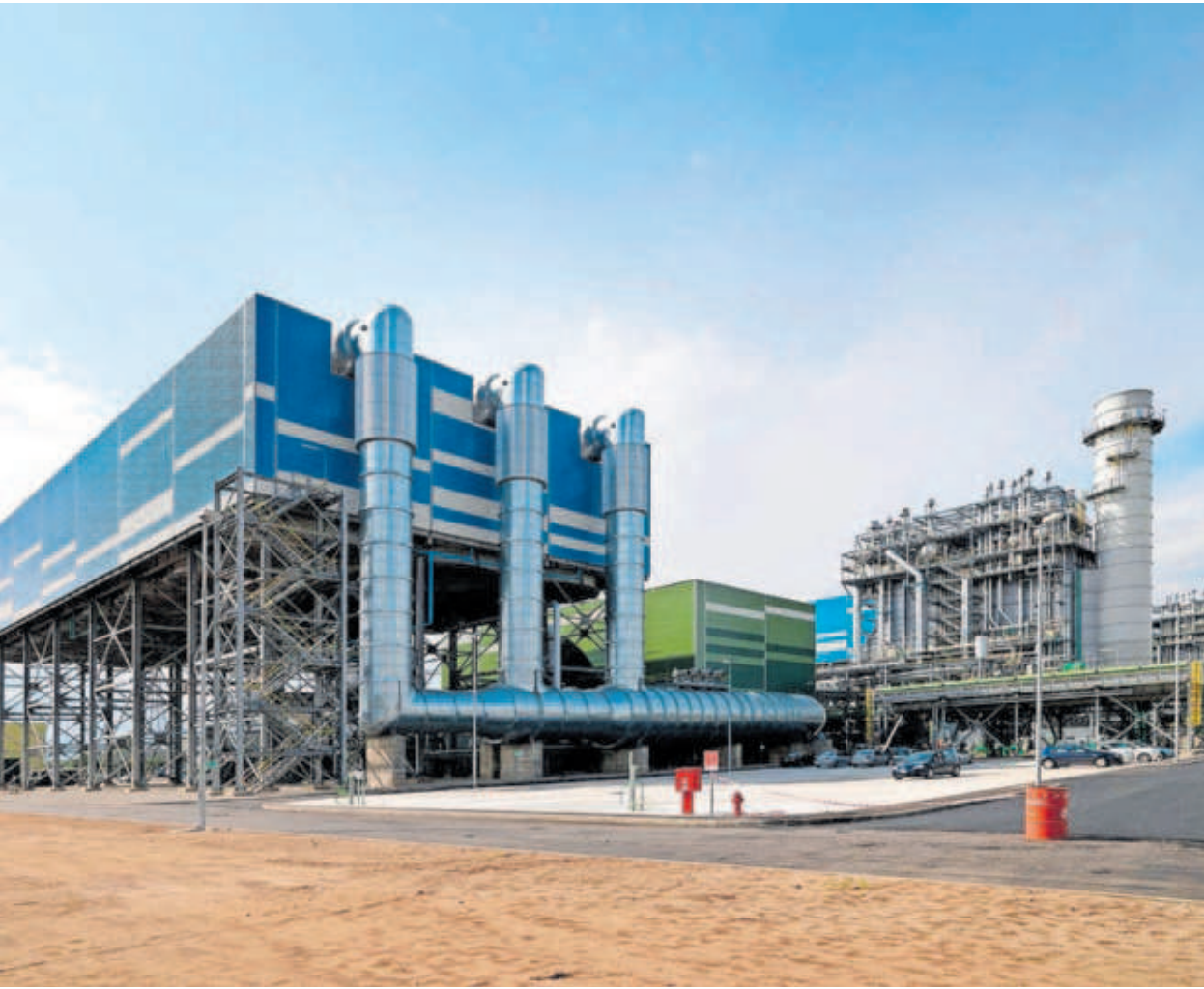
Planta de cogeneración. FOTO CEDIDA POR ACOGEN
