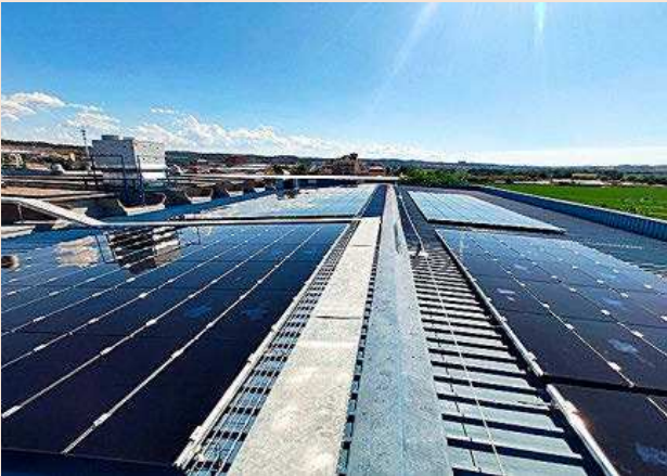
SolarProfit pone el foco en la instalación de placas fotovoltaicas.
