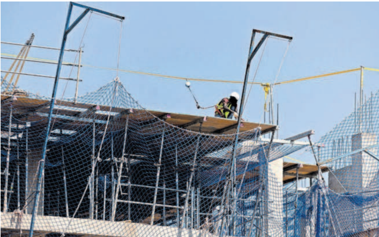
Viviendas en construcción el pasado mes de julio en Madrid. EUROPA PRESS
