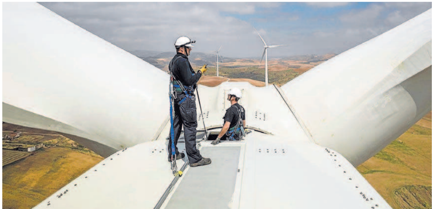
Dos operarios realizan labores de mantenimiento en un aerogenerador terrestre. e. c.
