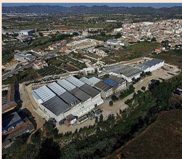
Vista aérea de la planta de Galol en L'Olleria (Valencia).
