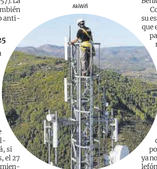
Instalación de la tecnología vía radio para conectarse a internet en Atzeneta. Al fondo se ve la población.
