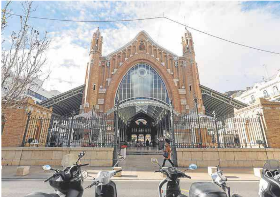
Acceso al Mercado de Colón por la calle Conde Salvatierra. IRENE MARSILLA
