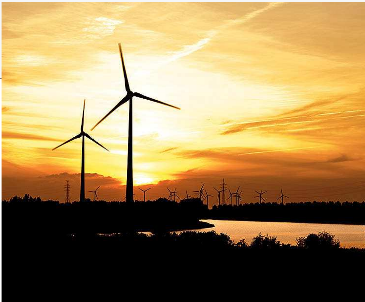
Planta eólica de Shneider Electric
