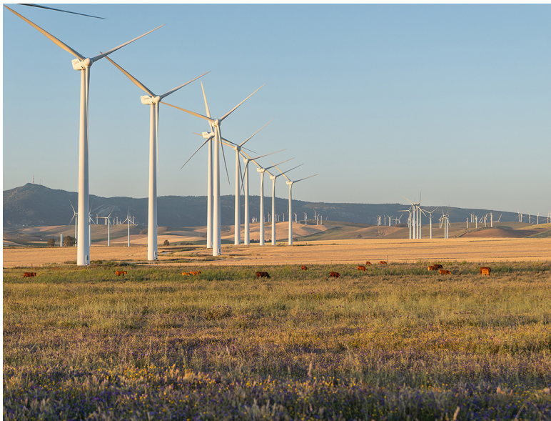
Parque eólico Tahivilla en Tarifa (Cádiz) de Acciona Energía. FOTO: Acciona Energía
