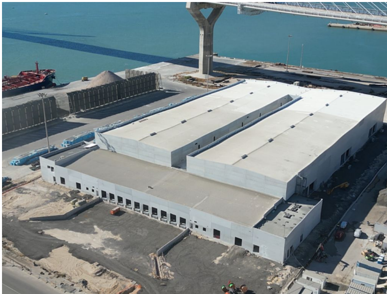
GreenYellow despliega en el Puerto de Cádiz su mayor proyecto europeo de frío industrial asociado a autoconsumo fotovoltaico.
