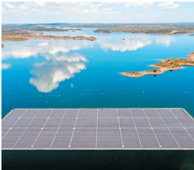
Paneles solares en Alqueva (Portugal), en una imagen cedida por EDP.
