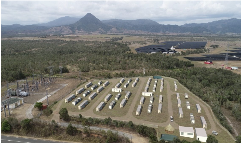
Akuo inicia la construcción de un megaproyecto de almacenamiento en la isla de Nueva Caledonia y allana el camino a las energías renovables
