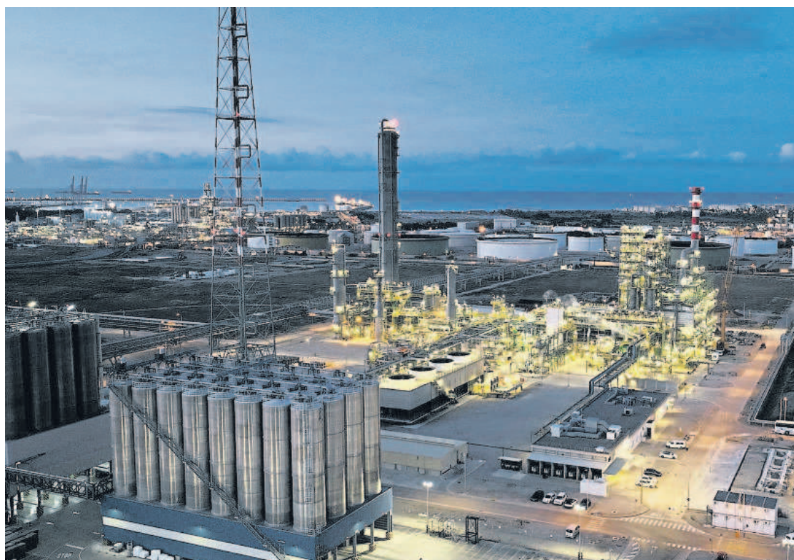
El complejo químico de BASF en Tarragona debía acoger una nueva planta de reciclaje de baterías de vehículos eléctricos
