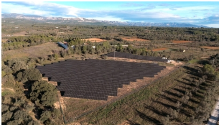
Campo solar fotovoltaico de Valfortec, la empresa fotovoltaica de Castellón
