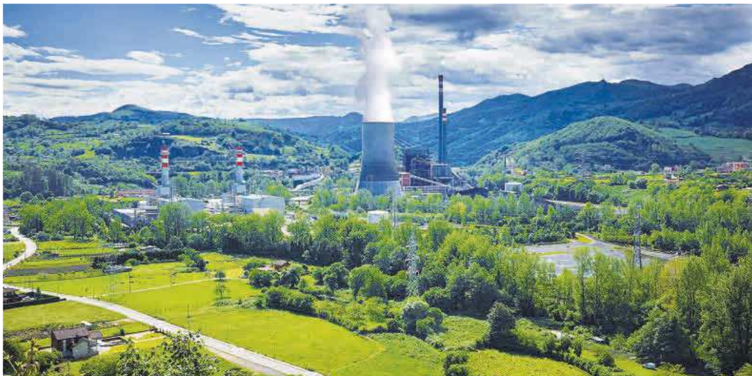
Vista general del complejo energético de EDP en Soto de Ribera, con dos ciclos combinados (gas natural) a la izquierda y las instalaciones de la térmica de carbón en el centro de la imagen.
