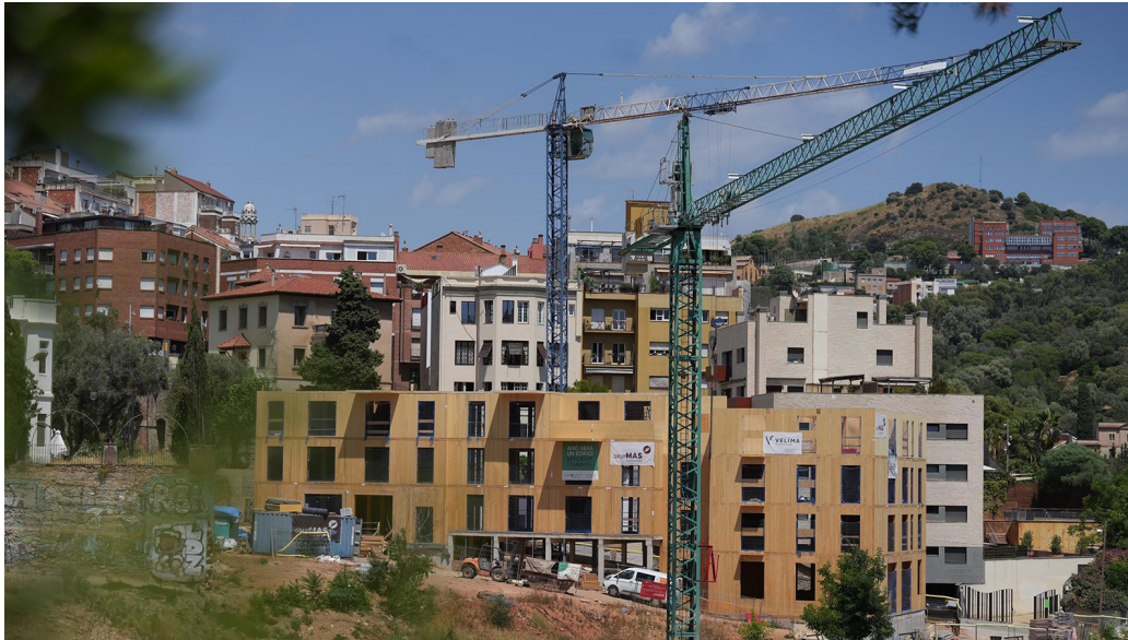
Construcción de un edificio sostenible en Vallcarca, a 31 de julio de 2025, en Barcelona, Cataluña (España).
