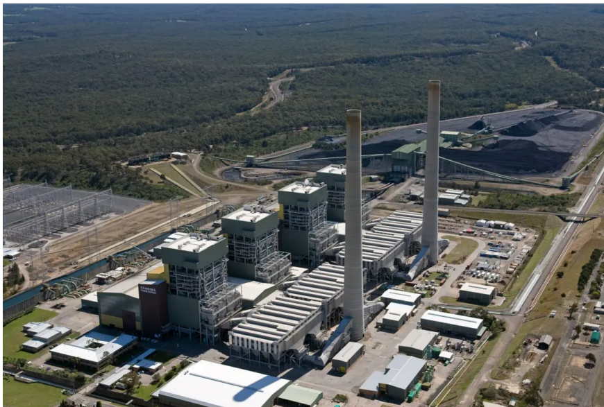
Central de carbón de Eraring, Australia.
