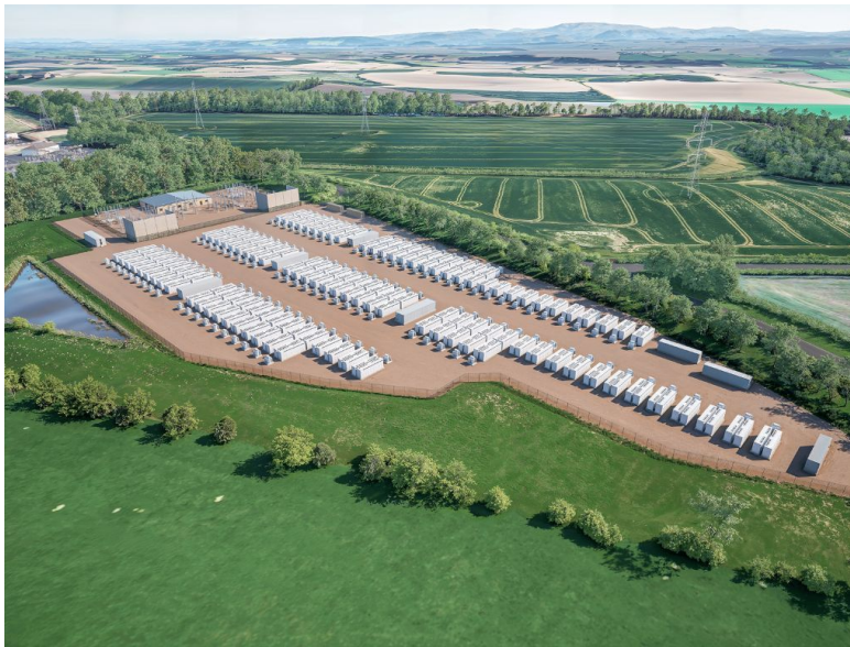
Matrix Renewables entra en el mercado británico con un sistema de almacenamiento de 1 GWh adjudicado a Tesla.
