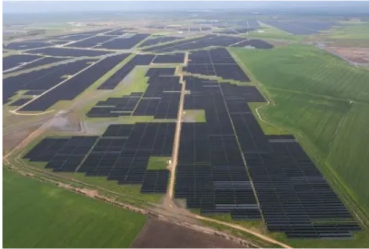
BRUC cierra 2025 con casi dos mil megavatios en operación
