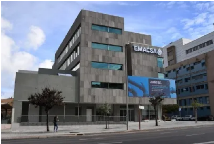
La Empresa Municipal de Aguas de Córdoba contará con una planta de autoconsumo en su sede central
