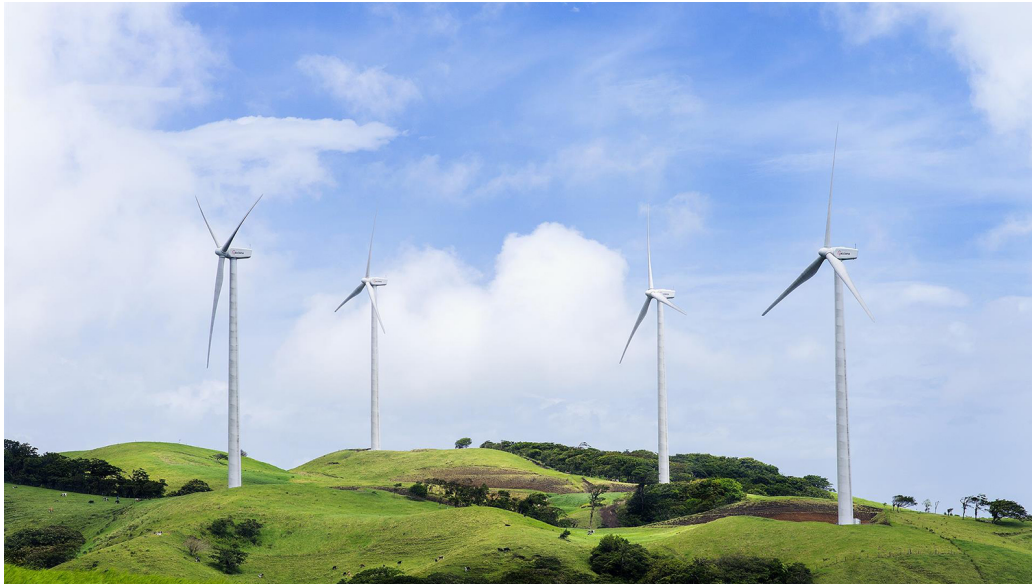
Parque eólico Chiripa de Acciona Energía.
