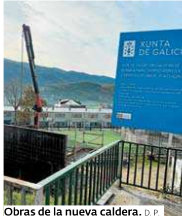
Obras de la nueva caldera. D. P.
