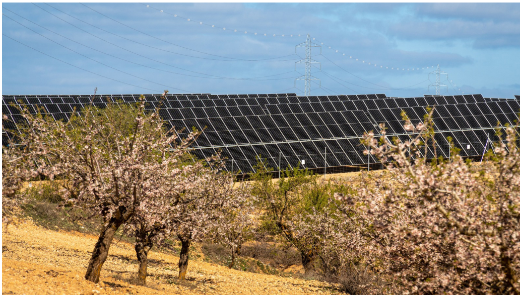
Planta fotovoltaica Covatillas de Sonnedix.
