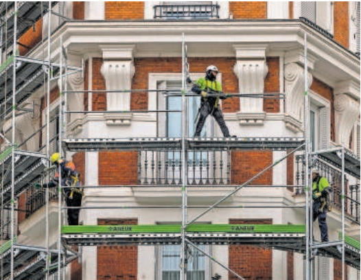
Una obra en la calle de Alcalá, en Madrid. SAMUEL SÁNCHEZ
