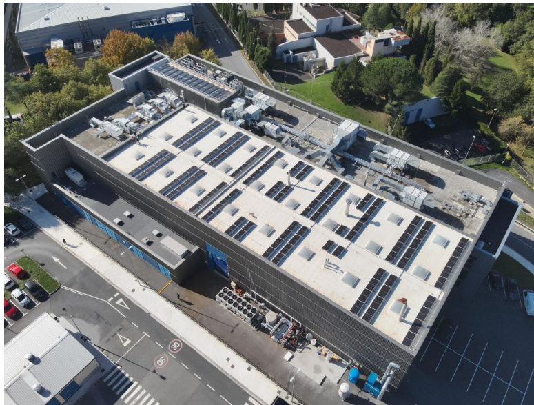
Edison Next instala 2 MW de autoconsumo para ITP Aero y construye la mayor marquesina solar del País Vasco.
