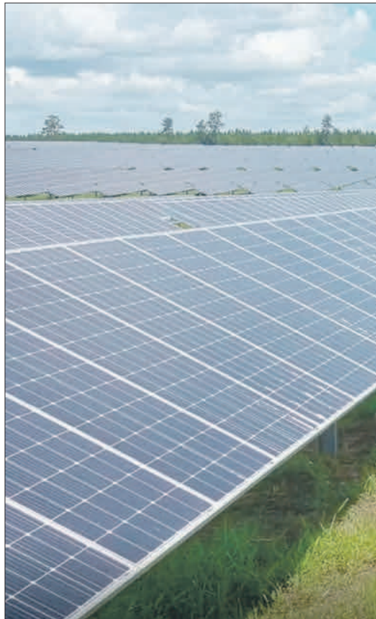
Complejo fotovoltaico. EE
