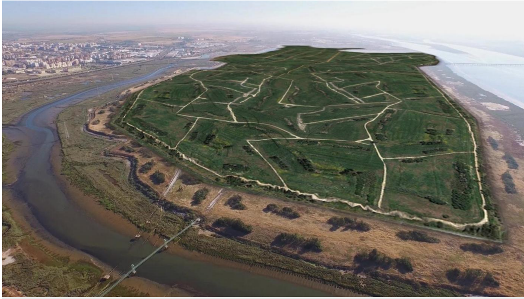
Reconstrucción del proyecto Restore 2030. - Grupo Fertiberia
