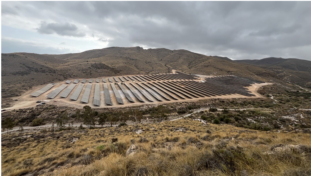
ISE Energía pone en marcha 10 MW para Cajamar.
