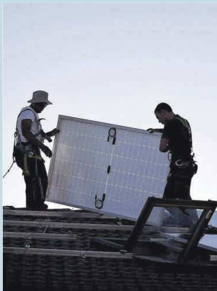
Dos operarios instalan placas solares fotovoltaicas en una vivienda.
