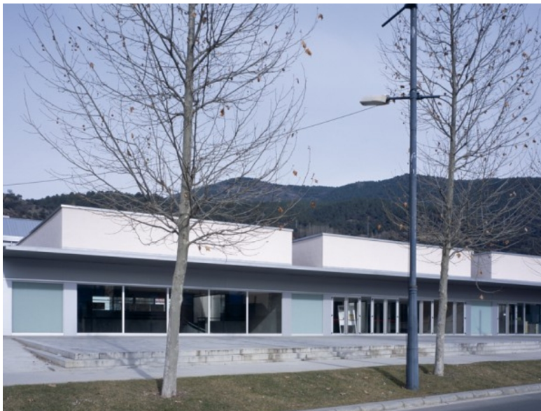
La Seu d'Urgell (Lleida) apuesta por la biomasa con una nueva instalación de district heating.
