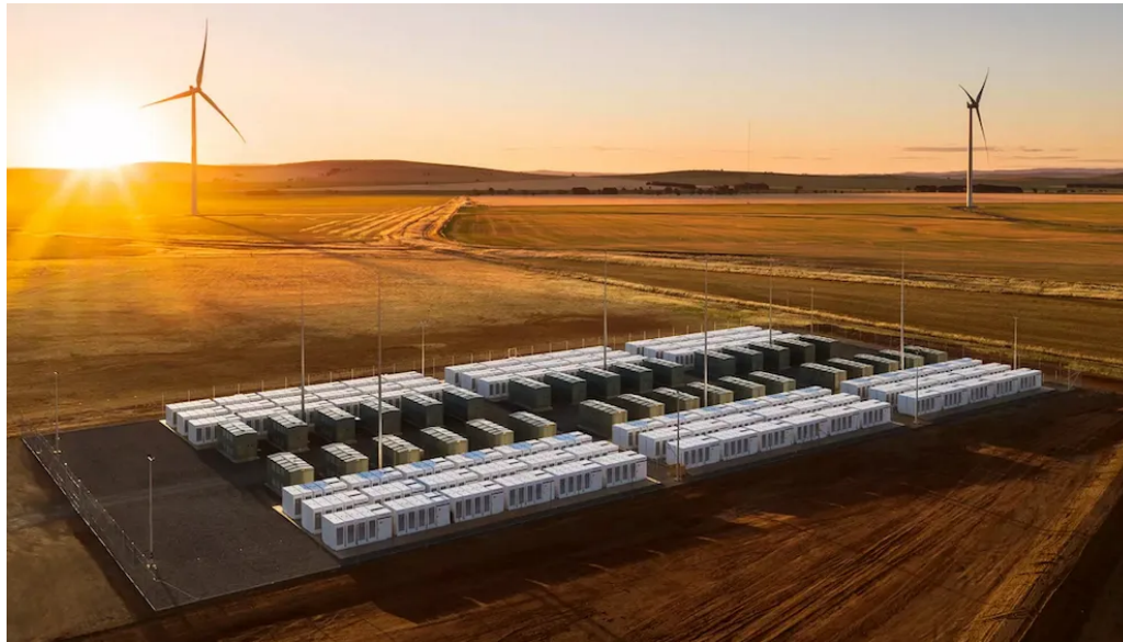
Sistema de almacenamiento de Tesla.
