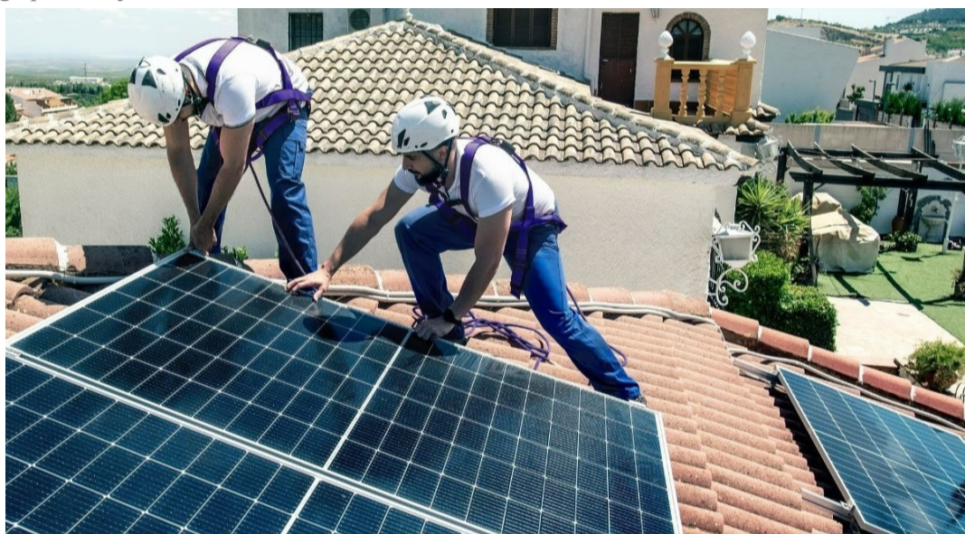
Operarios de Endesa instalan paneles solares en un tejado
