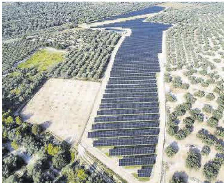
El parque solar fotovoltaico de Els Valentins, en Ulldedecona.
