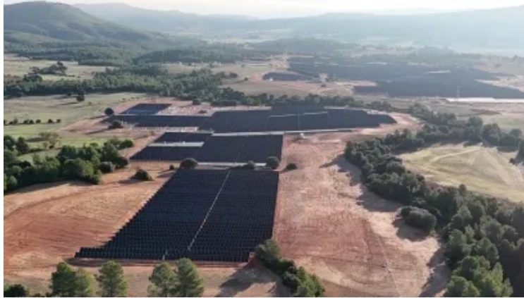
Planta fotovoltaica Ayora (Valencia)
