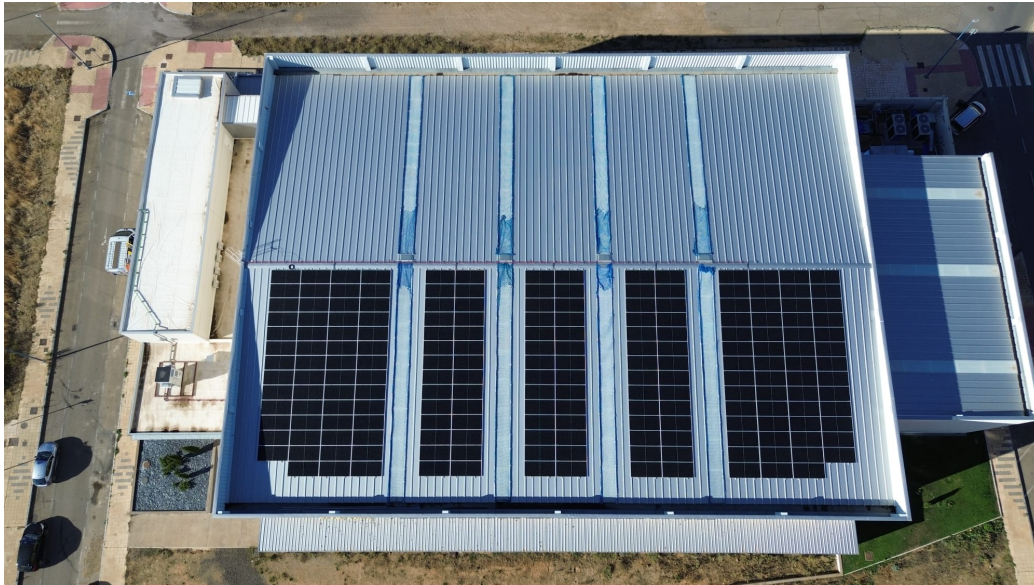
Transformando la energía pública en León: nueve sistemas de almacenamiento KSTAR impulsan la sostenibilidad municipal
