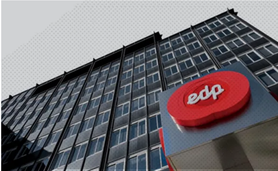
Edificio corporativo de la empresa energética portuguesa EDP
