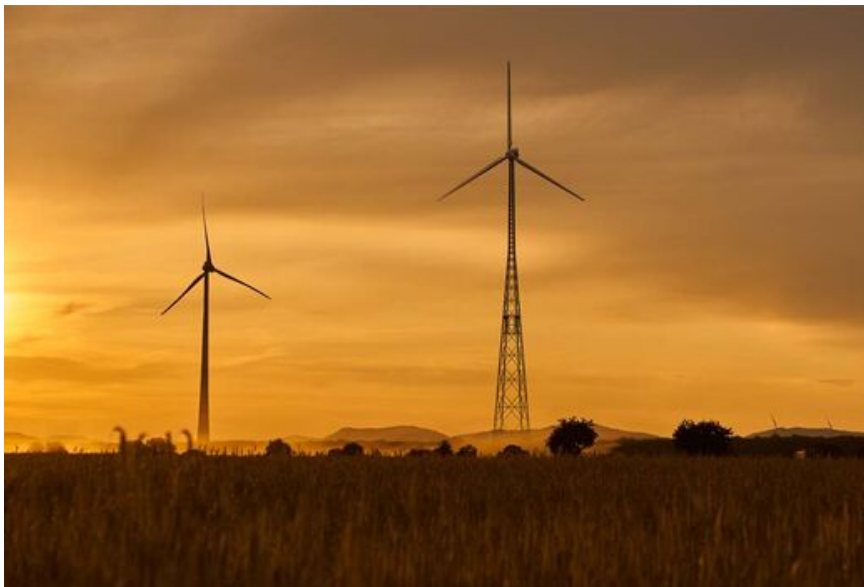
Comienza la construcción del aerogenerador más alto del mundo en Alemania con 300 metros de altura de torre
