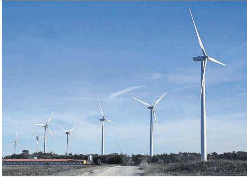
Parque eólico en el término municipal de Veciana (Añoia).
