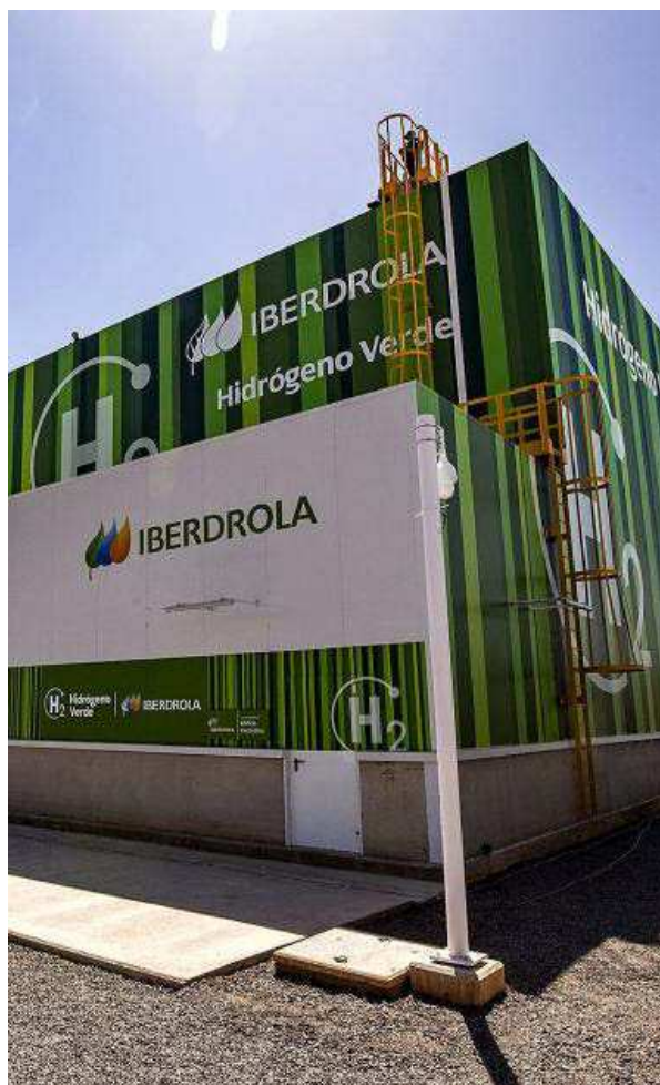
Planta de hidrógeno verde de Iberdrola en Puertollano. / RUEDA VILLAVEVERDE
