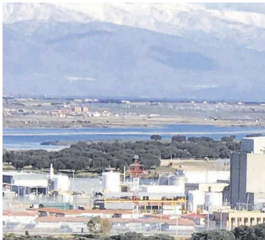
La central nuclear de Almaraz, en Cáceres, el cierre de cuyos reactores está previsto para 2027 y 2028.
