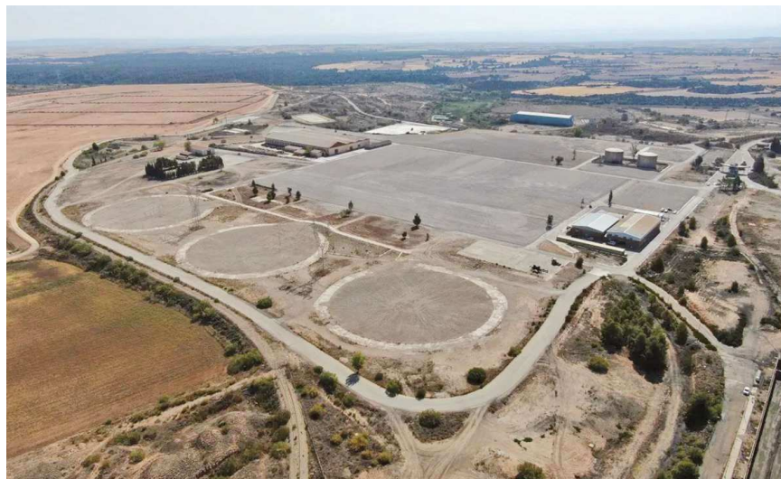
Imagen desde las alturas donde se ubicaba la antigua central térmica de Andorra. Endesa
