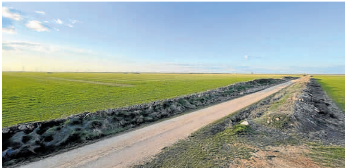
Terrenos donde se va a construir el mega parque de energía fotovoltaica. L. N.
