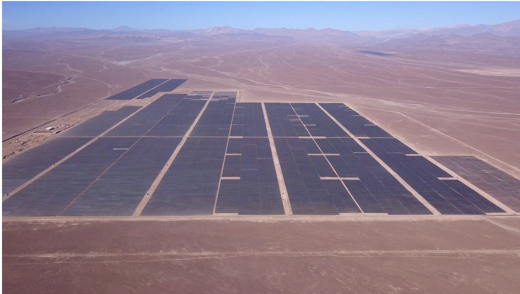
Acciona Energía instalará una batería de un GWh de capacidad en el desierto de Atacama.
