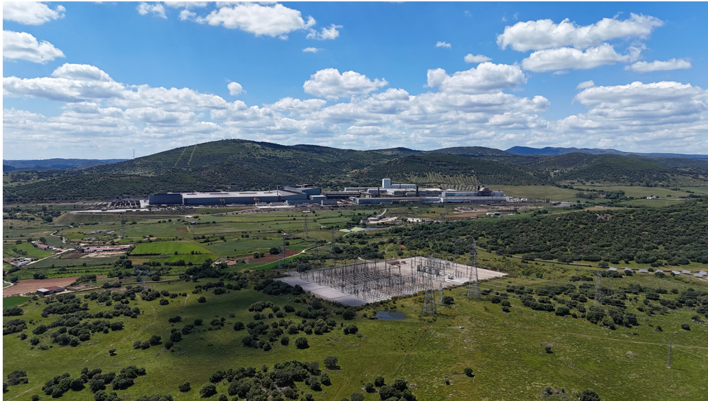
La nueva planta solar fotovoltaica 'El Corchito' de CL Grupo Industrial.
