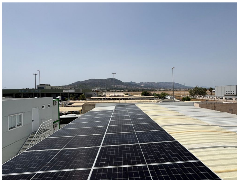
Málaga estrena el primer proyecto fotovoltaico privado en un aeropuerto español diseñado para evitar el deslumbramiento aéreo.
