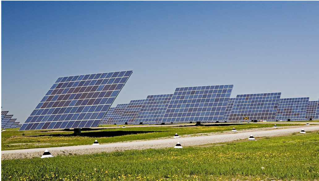
Planta fotovoltaica de Acciona Energía.
