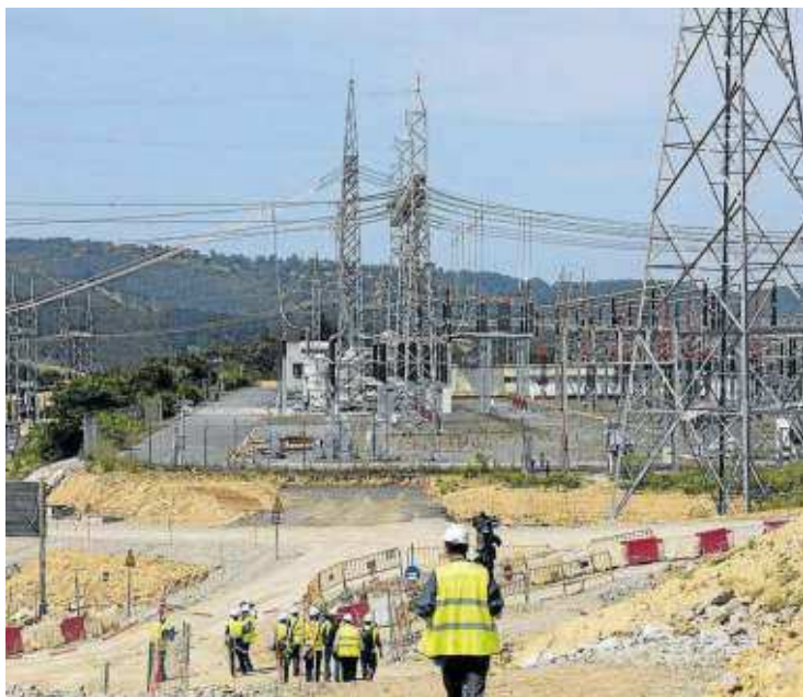
Obras de interconexión de Red Eléctrica en Gatika. Foto: Pankra Nieto
