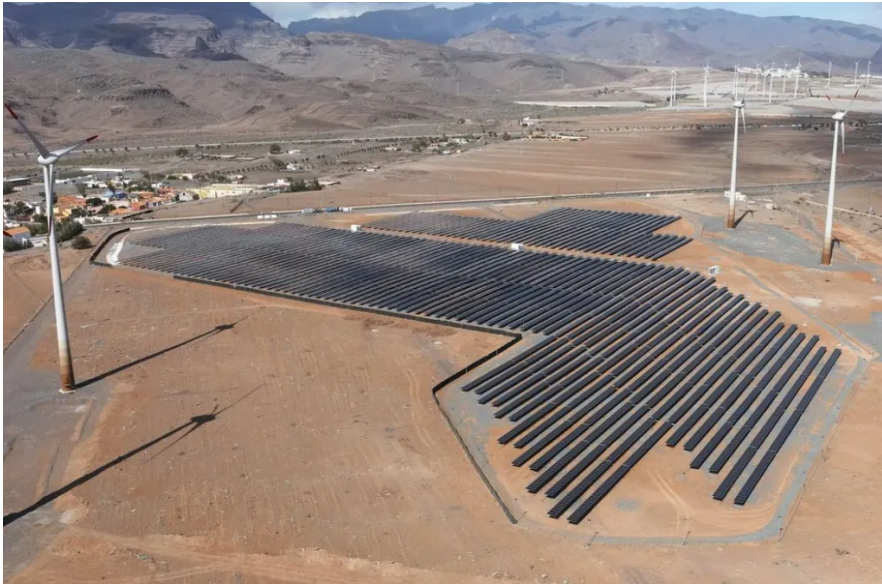
Parque solar fotovoltaico de Ecoener en la isla de Gran Canaria. Aldea Blanca III. Fuente foto: Ecoener
