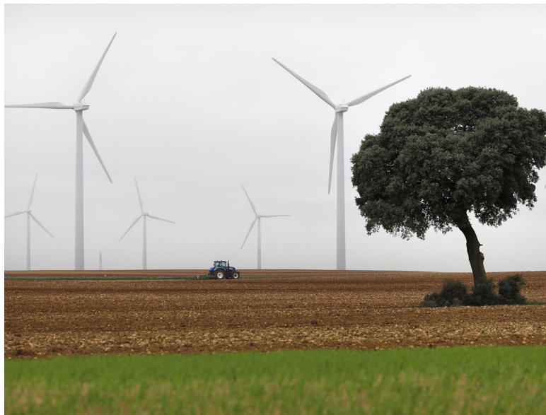
Parque eólico de Iberdrola en Castilla y León.
