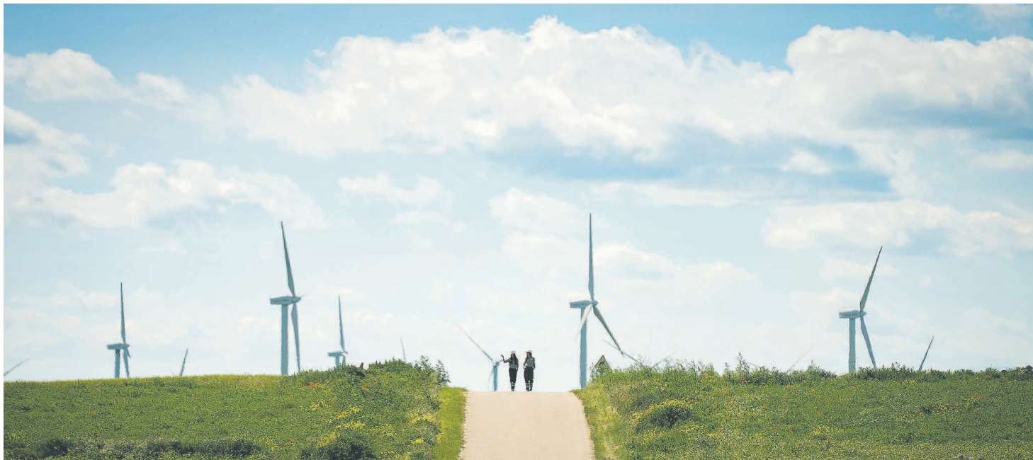
Parque eólico de Iberdrola en Castilla y León
