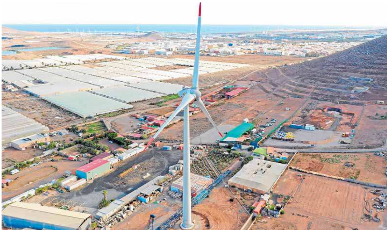
El aerogenerador del parque Renove II ya está instalado en el recinto de Ayagaures Medioambiente en Agüimes. CANARIAS7
