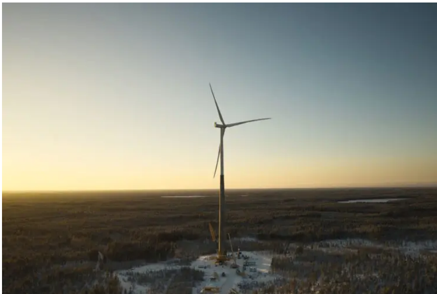
Aerogenerador de Nordex.
