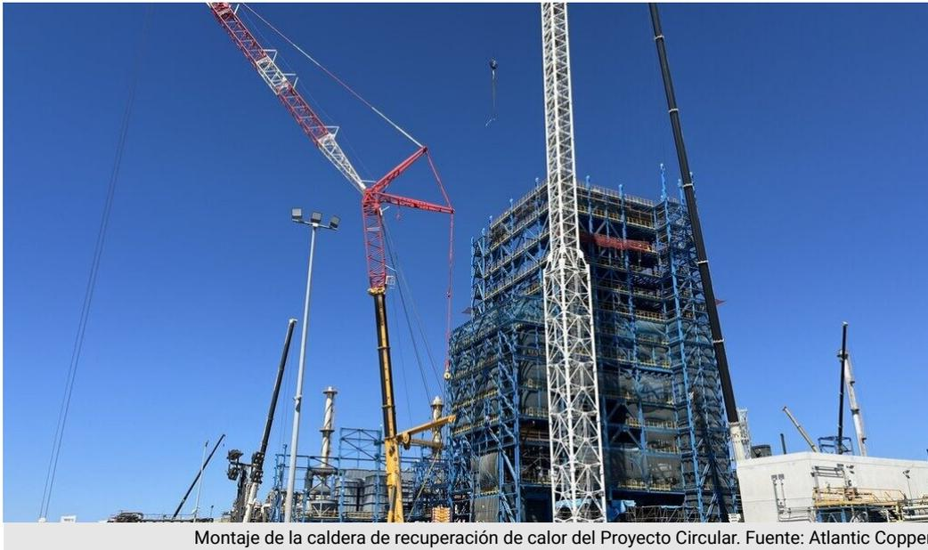
Montaje de la caldera de recuperación de calor del Proyecto Circular. Fuente: Atlantic Copper
