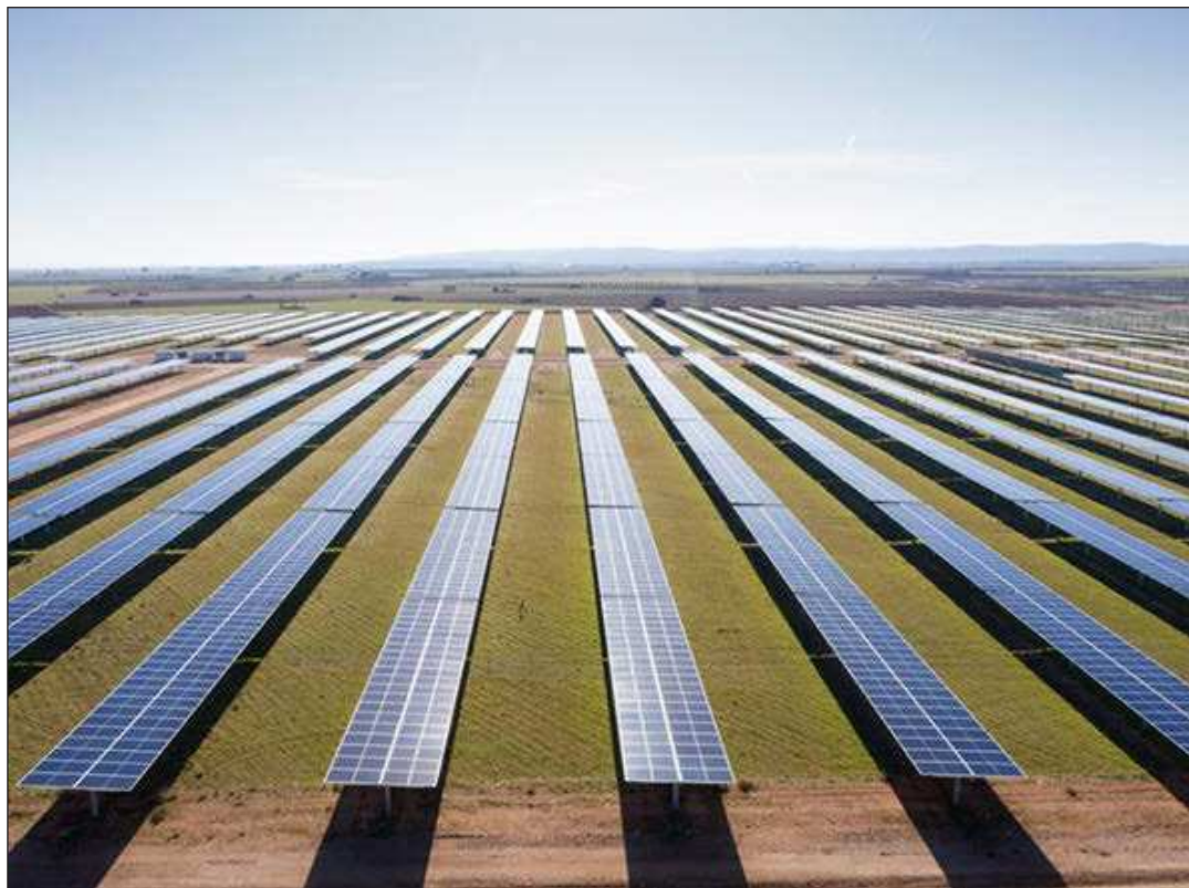
Planta fotovoltaica desarrollada por Cox. EE
