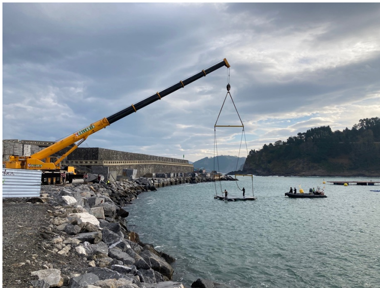
Tecnalia instala en Mutriku una innovadora estructura flotante fotovoltaica
