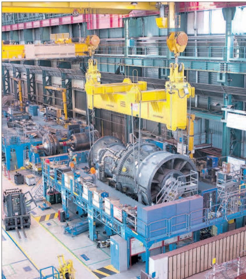
Una turbina de una central de ciclo combinado de gas. EE
