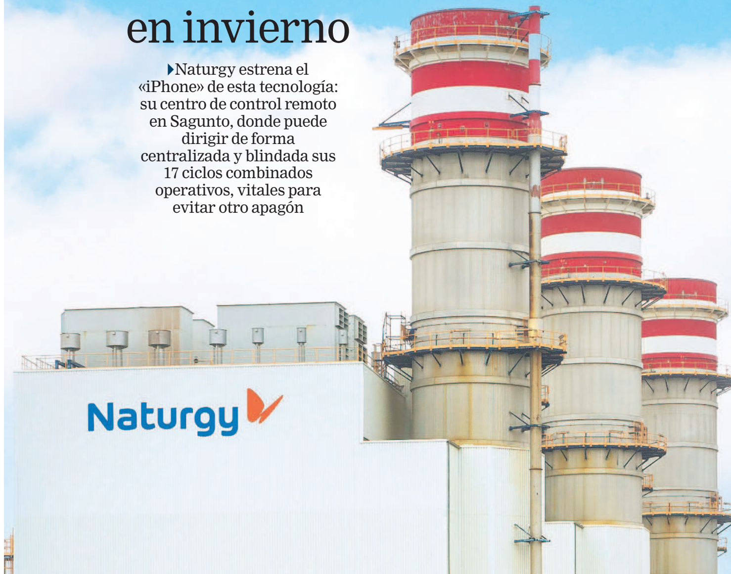
La planta de Sagunto (Valencia) opera a pleno rendimiento y centraliza la operativa de toda la flota de ciclos de Naturgy
