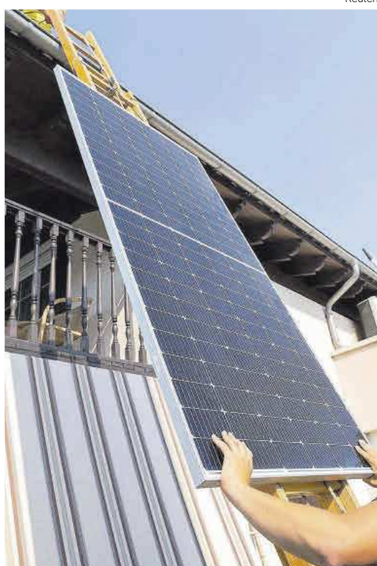
Instalación de placas solares.
