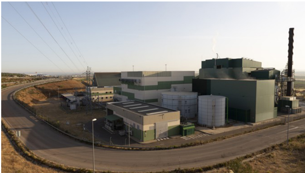
Schneider Electric y Magnon impulsan la eficiencia y la sostenibilidad en la planta de biomasa de Mérida.
