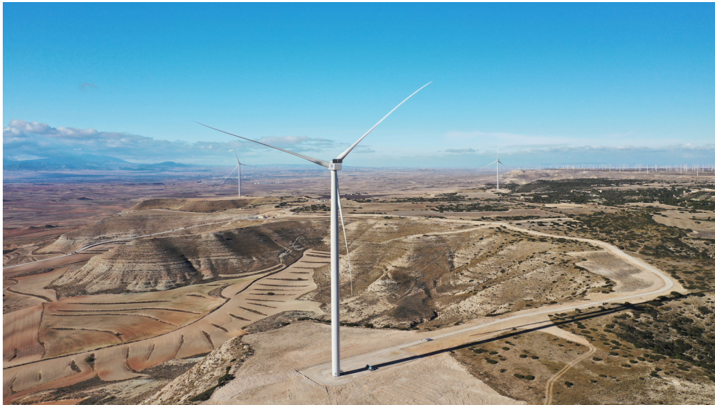
Repotenciación con cero residuos: RWE pone en marcha su parque eólico de Muel, en Aragón.
