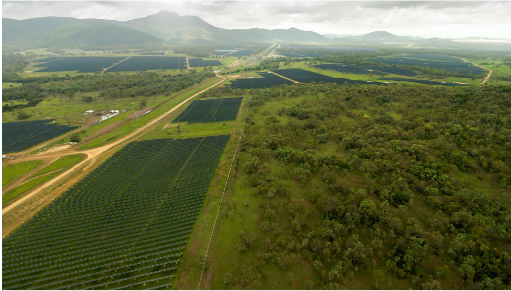
Planta solar de Acciona Energía.
