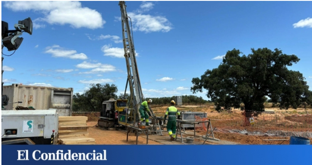
Foto: Sondeo de Pan Global en el municipio sevillano de Aznalcóllar. (Foto: José Luis Losa)
