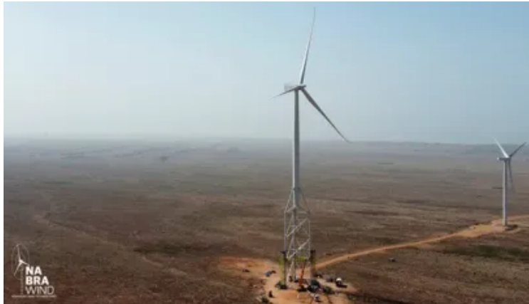
Nabrawind suministrará 17 torres eólicas de 188 metros para descarbonizar la minería en Australia
