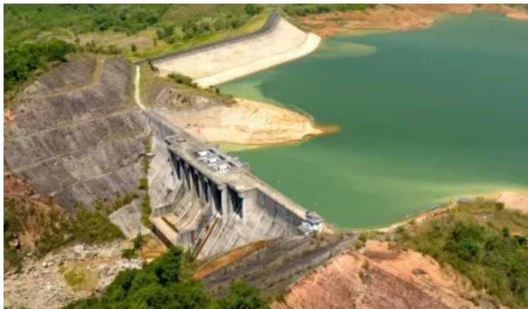
Central hidroeléctrica. Fuente: Ministerio para la Transición Ecológica y el Reto Demográfico
