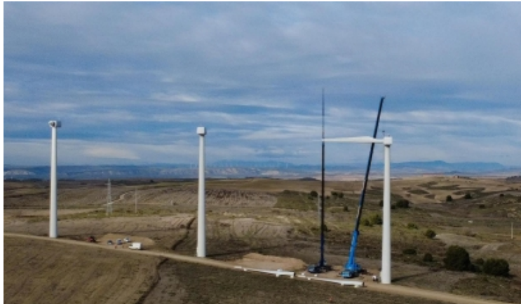
RenerCycle gana el desmantelamiento y reciclaje de tres parques eólicos de Grupo Enhol
