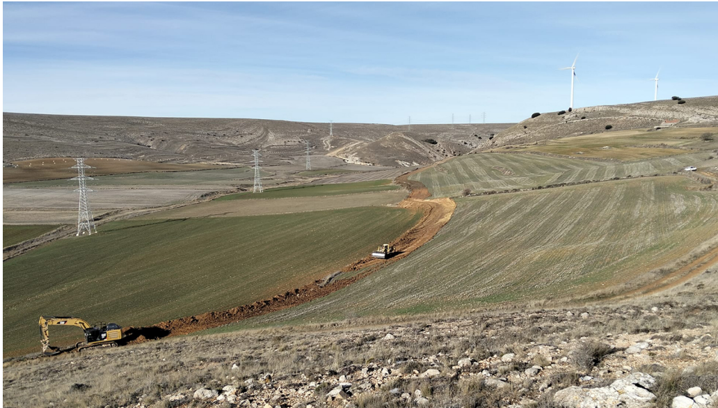
Ecay Construcciones inicia la ejecución de dos parques eólicos de la escocesa SSE Renewables en Teruel.
