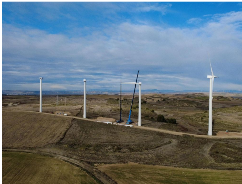
RenerCycle desmantelará tres parques eólicos de Grupo Enhol en Navarra para su repotenciación.
