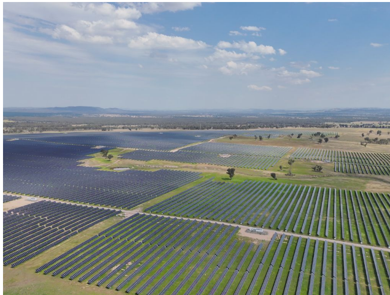
Solarig supera los 2 GW de activos renovables en operación y mantenimiento en Australia con el proyecto solar Stubbo.
