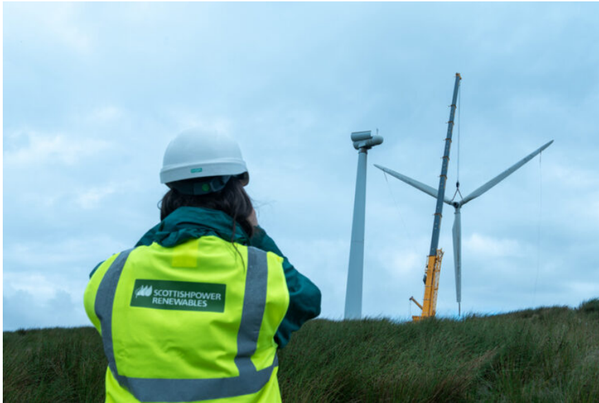
Labores de repotenciación del parque eólico Hagshaw Hill de ScottishPower.
