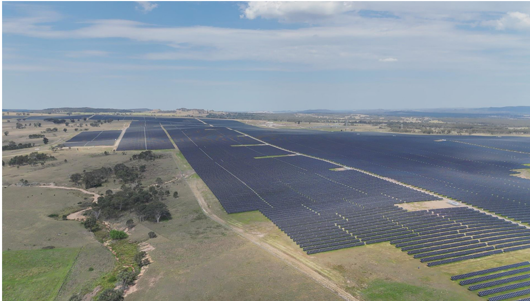
Solarig alcanza los 2 GW en Australia con la entrada en operación de un proyecto solar de 520 MW.
