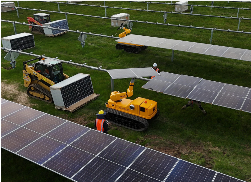
Robot instalador de paneles solares en el proyecto solar de Goorambat.
