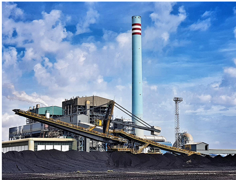
Endesa, central térmica, Carboneras.
