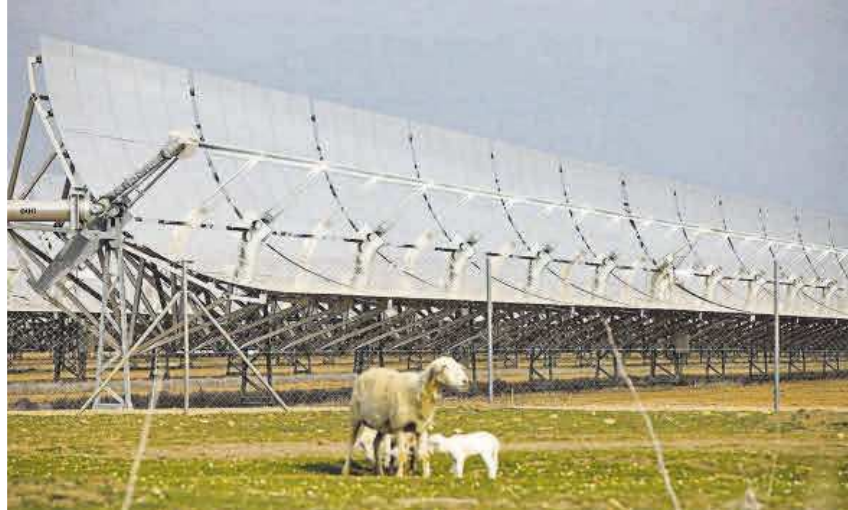
Imagen de archivo de una planta fotovoltaica.
