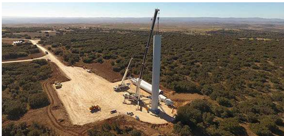
Parque eólico en construcción. eE
