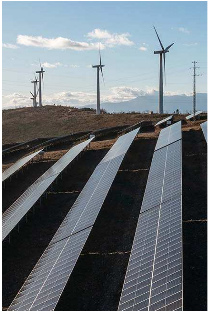
Parque híbrido solar y eólico. eE
