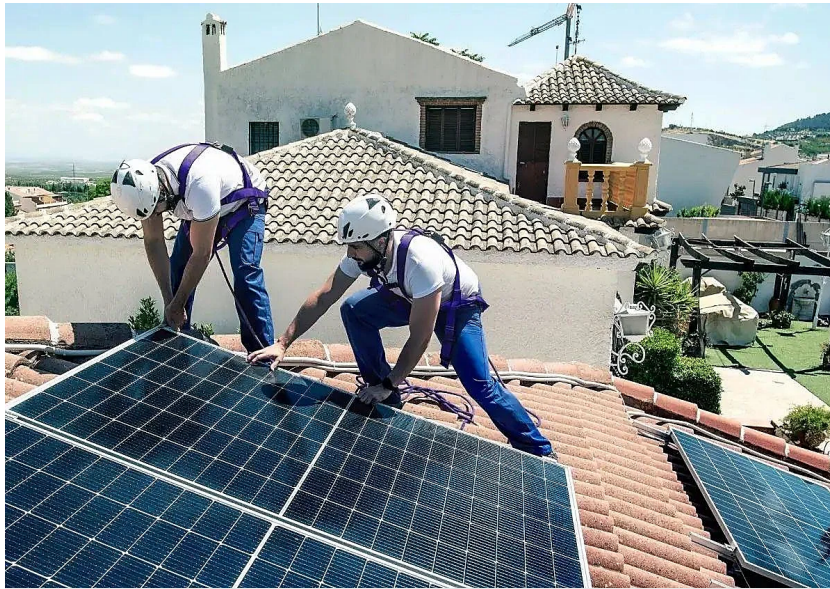
Dos trabajadores instalan una placa solar en un domicilio
