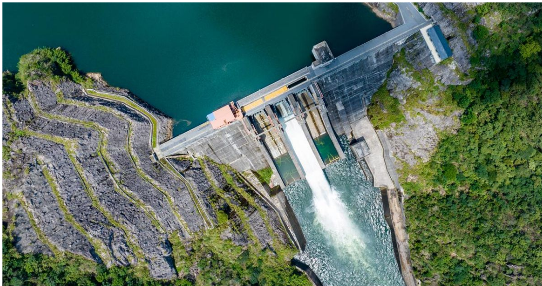
Vista aérea de una presa hidráulica
