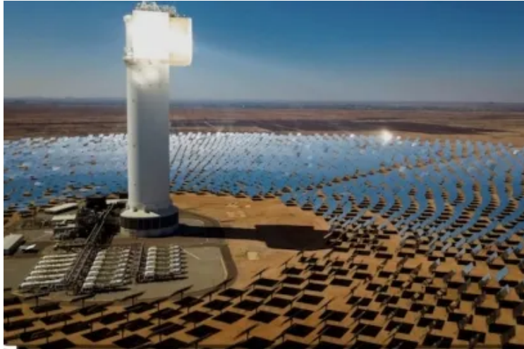
Nuevos pasos hacia la digitalización completa de las plantas termosolares de torre
