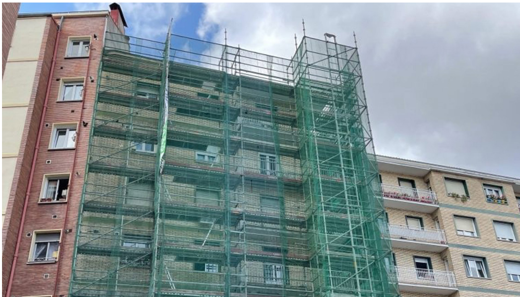
Rehabilitación de vivienda,
