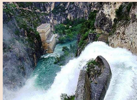
Central hidráulica de Camarasa (Noguera), operada por Endesa.
