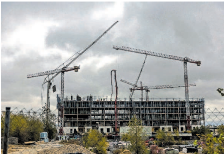
Viviendas en construcción en el área residencial de Valdebebas (Madrid), el lunes. S. SÁNCHEZ
