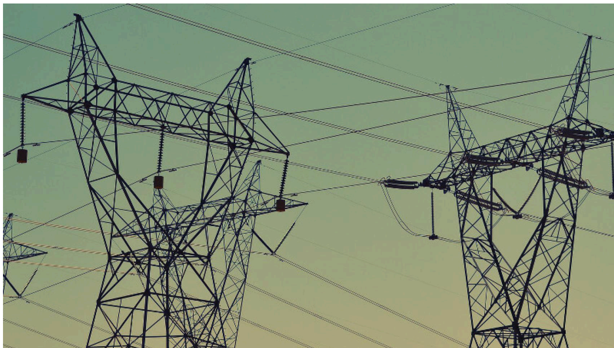
Torres eléctricas./ EE
