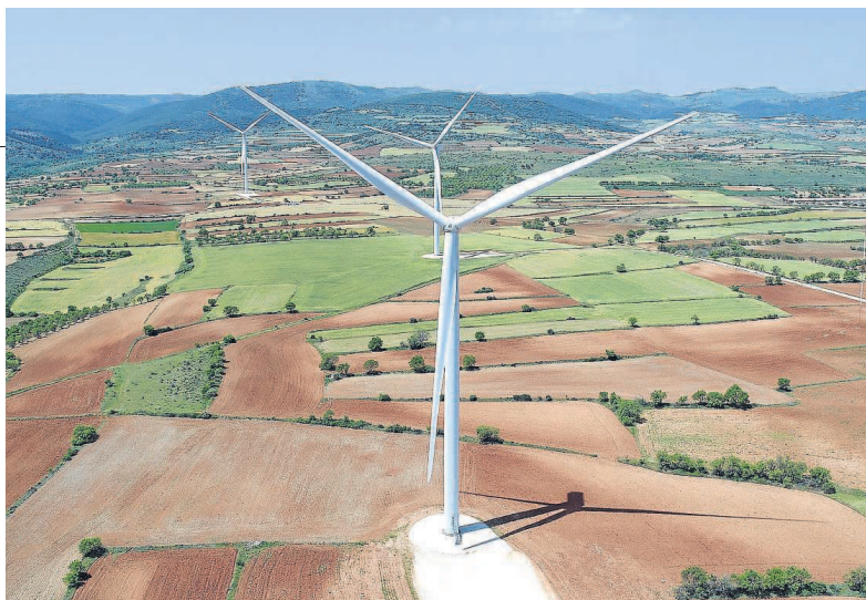
Foto aérea de un parque eólico promovido por Forestalia en Monforte de Moyuela. J. OCHOA
