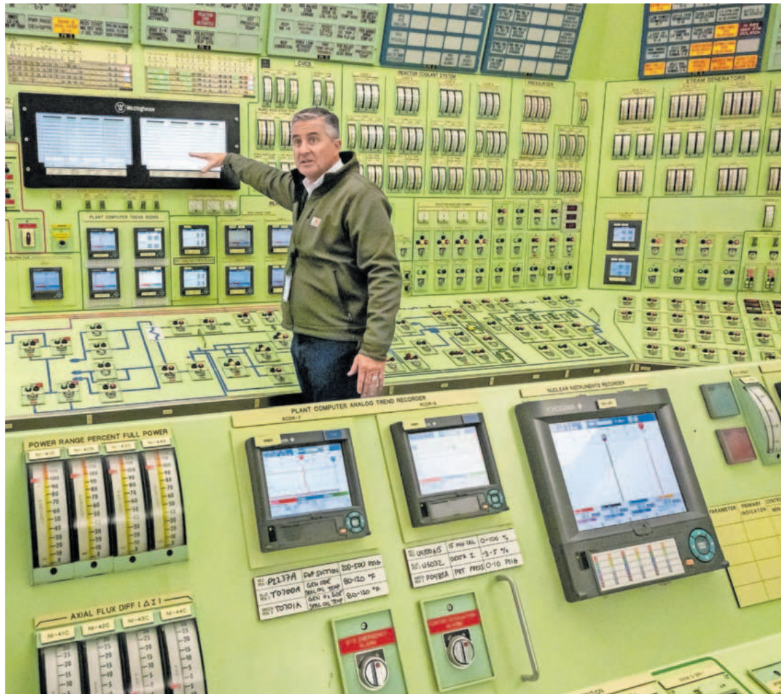
Interior del simulador de la sala de control en la planta nuclear Diablo Canyon en Avila Beach (California, EE UU). DAVID PAUL (BLOOMBERG)
