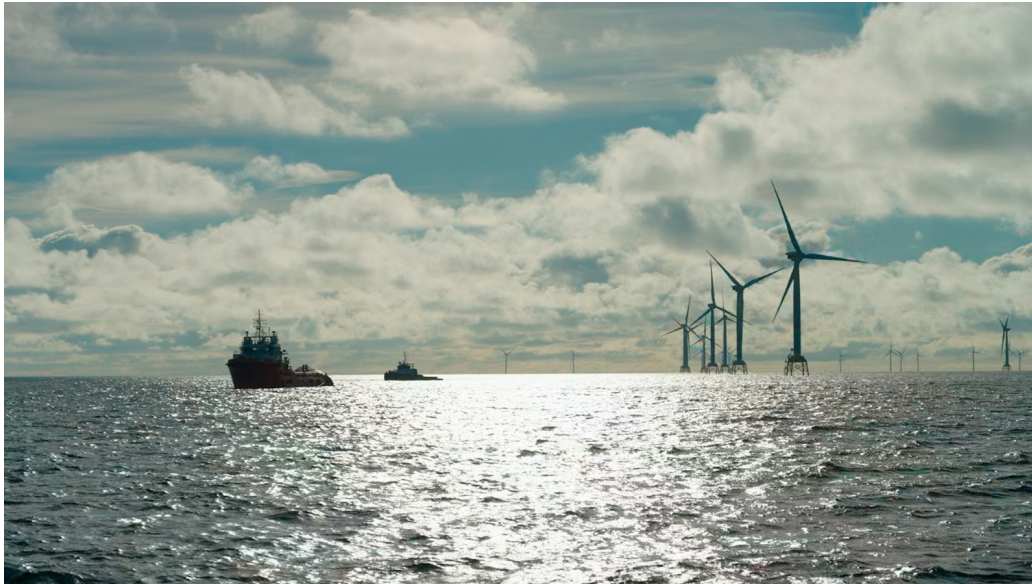
El parque eólico marino Windanker de Iberdrola.
