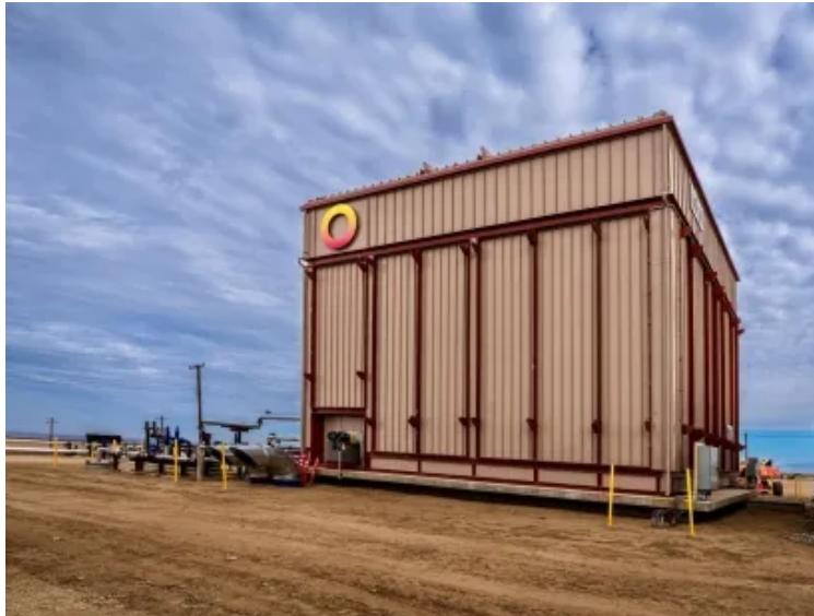
Instalaciones de Ciuden donde se ubicará la planta piloto de producción de metanol
