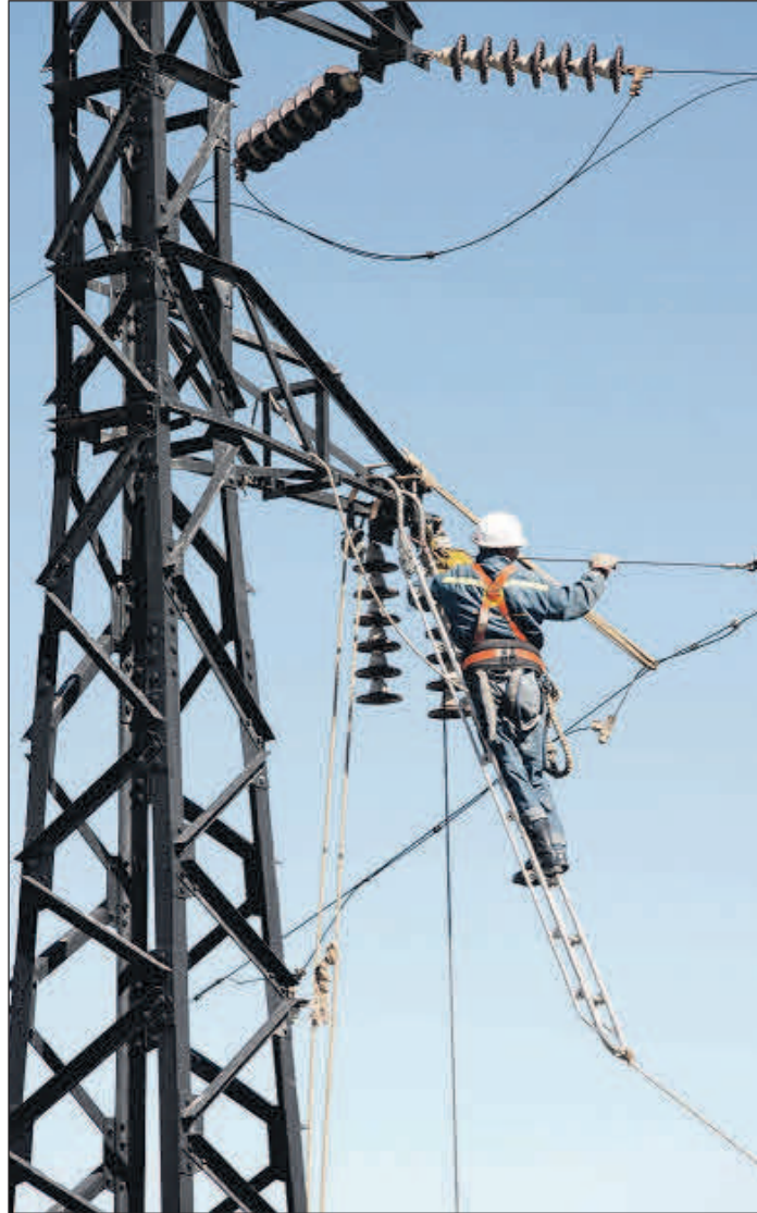
Un electricista trabaja en una torre de electricidad. ISTOCK
